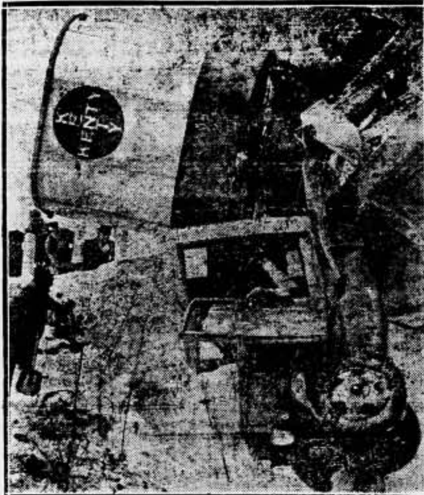
Un camión cargado de huevos se precipita sobre la baranda de un puente, siendo detenido, en la forma que puede observarse, por un simple tornillo del coche, que quedó empotrado en la armadura del puente, resultando ileso el conductor y las no menos frágiles mercancías
