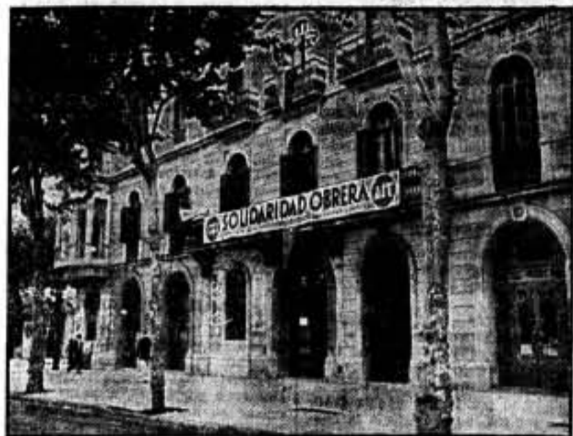
El nuevo local de la Redacción de SOLIDARIDAD OBRERA, situado en la Ronda de San Pedro, núm. 52.
