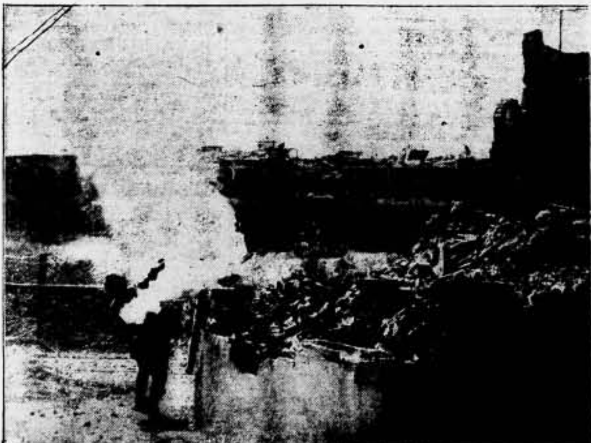
Un soldado japonés lanzando una bomba incendiaria a una fila de casas que sirve de parapeto a los soldados chinos. En primer término, pueden apreciarse las ruinas de lo que fué hace poco una casa moderna de esta plaza. El fotógrafo que se atrevió a obtener esta fotografía fué gravemente herido.
