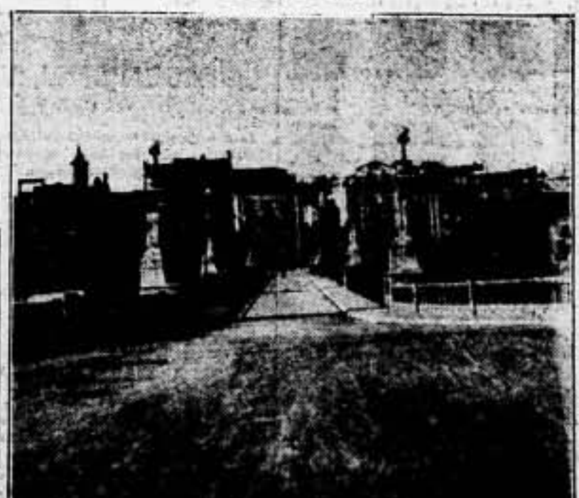
Entrada a Teruel por la carretera de Valencia, Puente del Viaducto, cuya voladura no pudieron efectuar los fasciosos ante la acometividad de nuestras fuerzas
