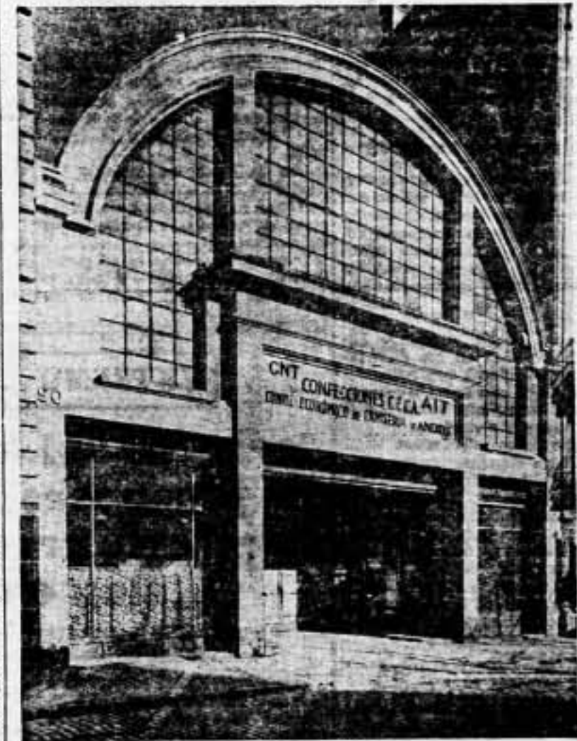
Vista de la fachada de los Talleres Confederales de Camisería
